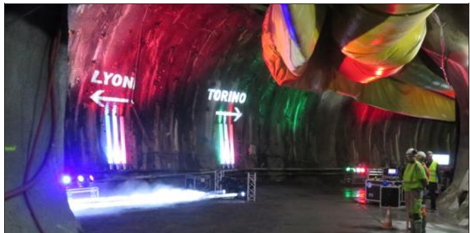
■ Le chantier souterrain du Lyon-Turin ; à Saint-Martin-la-Porte en Maurienne, lors d'une visite en octobre dernier.
