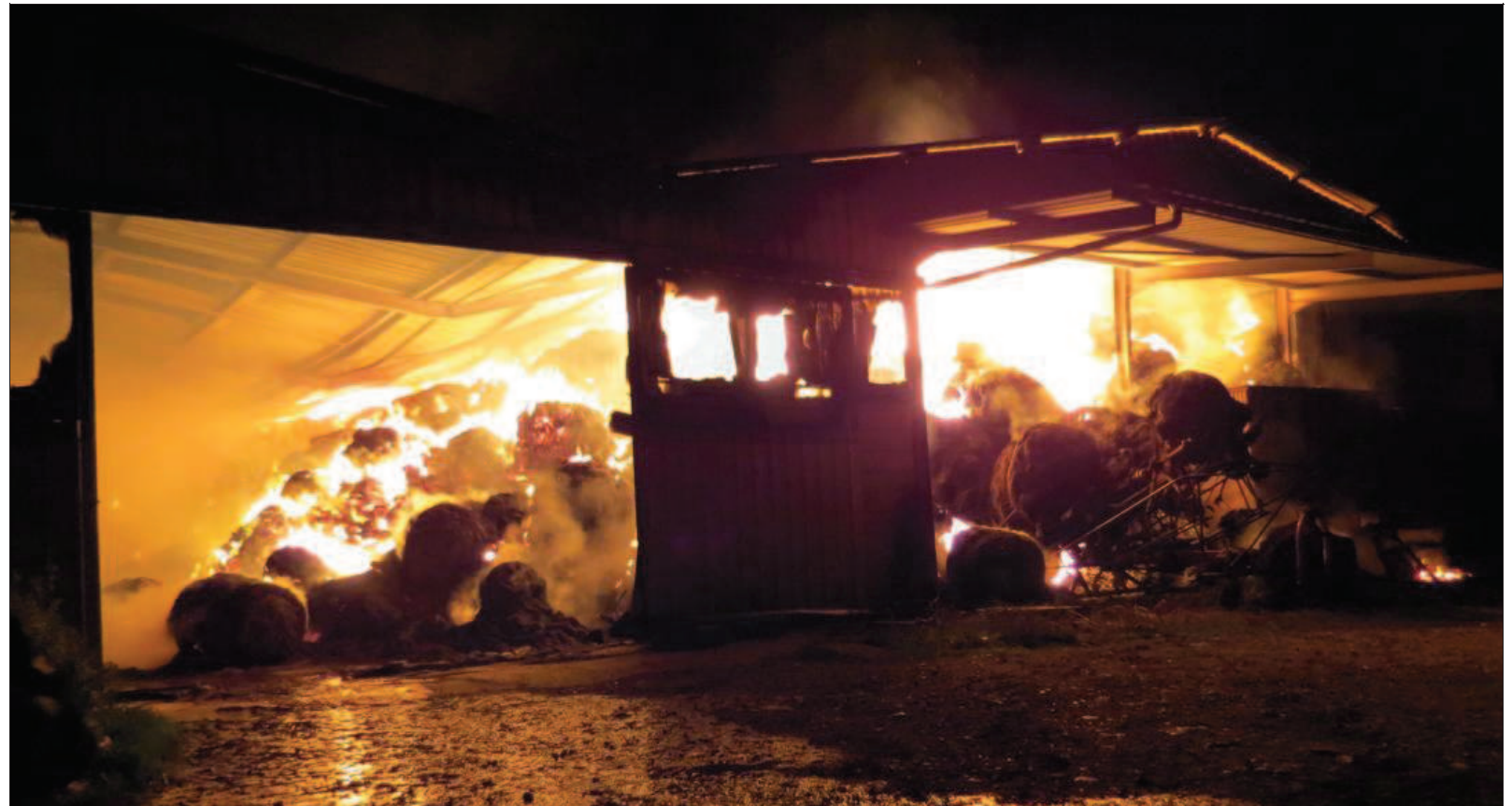
■ À l'arrivée des pompiers, les hangars et leurs stockages étaient totalement embrasés.
